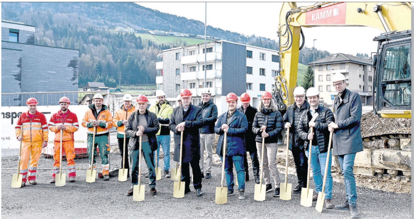
Versammelt zum Spatenstich: die Verantwortlichen für das Projekt «Roggenacker» in Pfäffikon.
